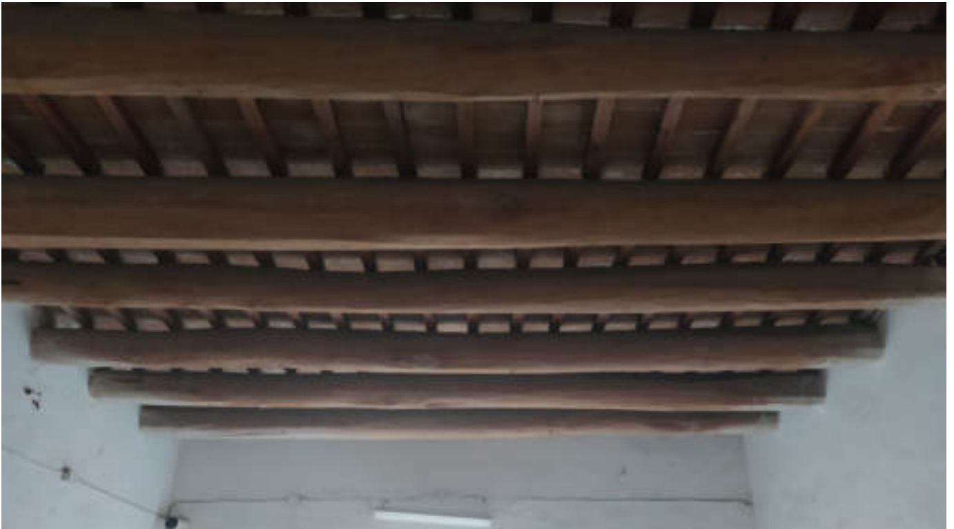
Corridoio sul cortile: solaio esistente in legno
