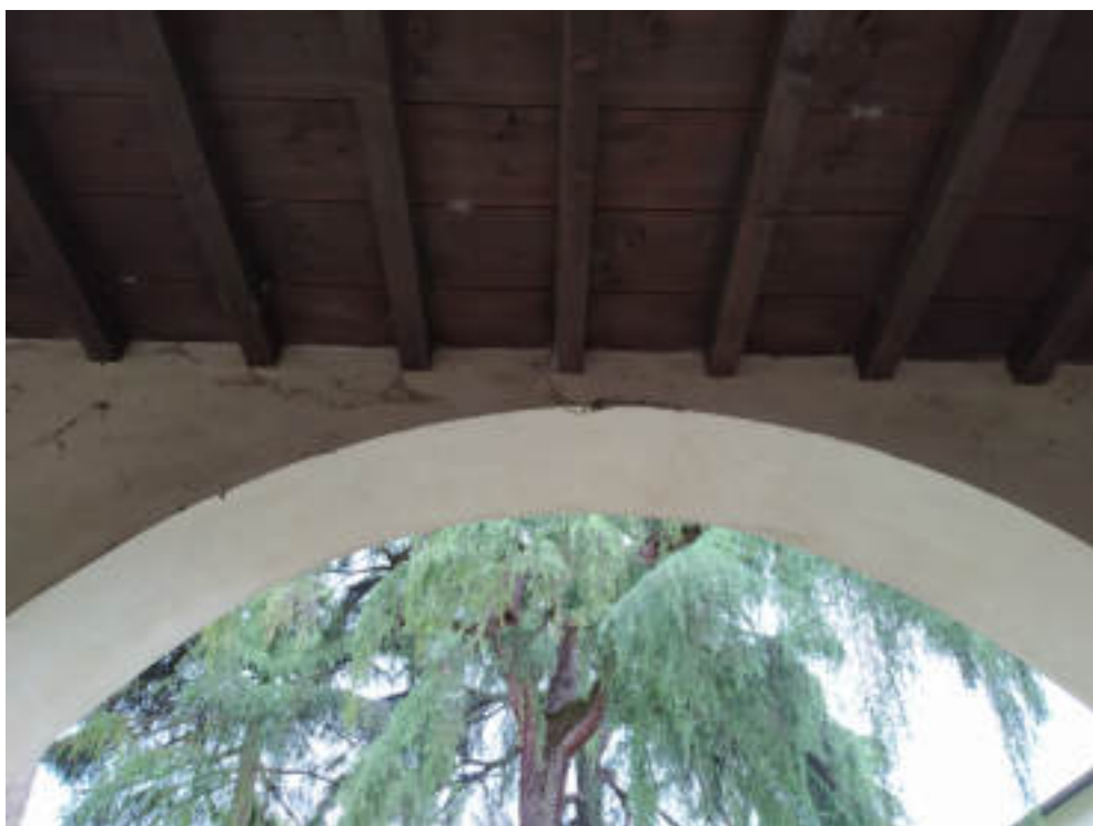
solaio esistente in legno nel loggiato sul cortile centrale
