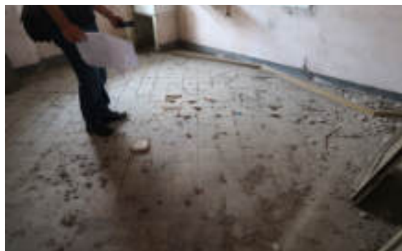
Pavimento in cotto esistente
