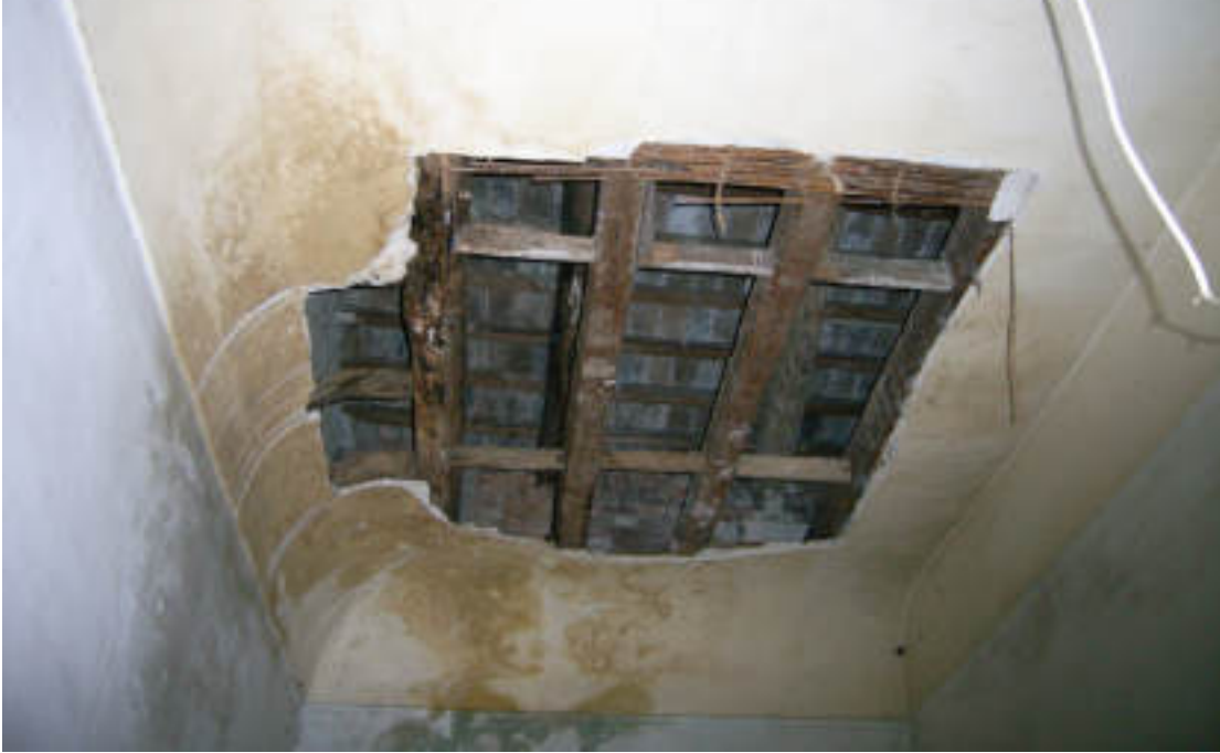
CONTROSOFFITTURE: Primo Piano, zona aule
